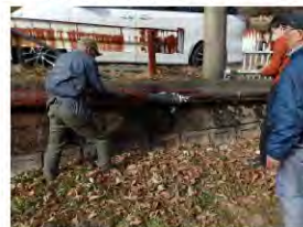
使用していない温泉配管を外している作業
