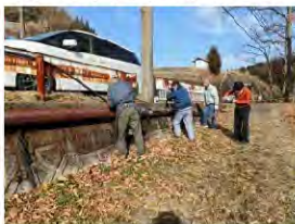
使用していない温泉配管を外している作業
