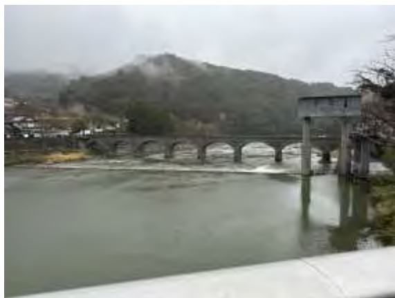
耶馬溪橋(オランダ橋)は、災害からの修復中のため渡ることができなかった。
