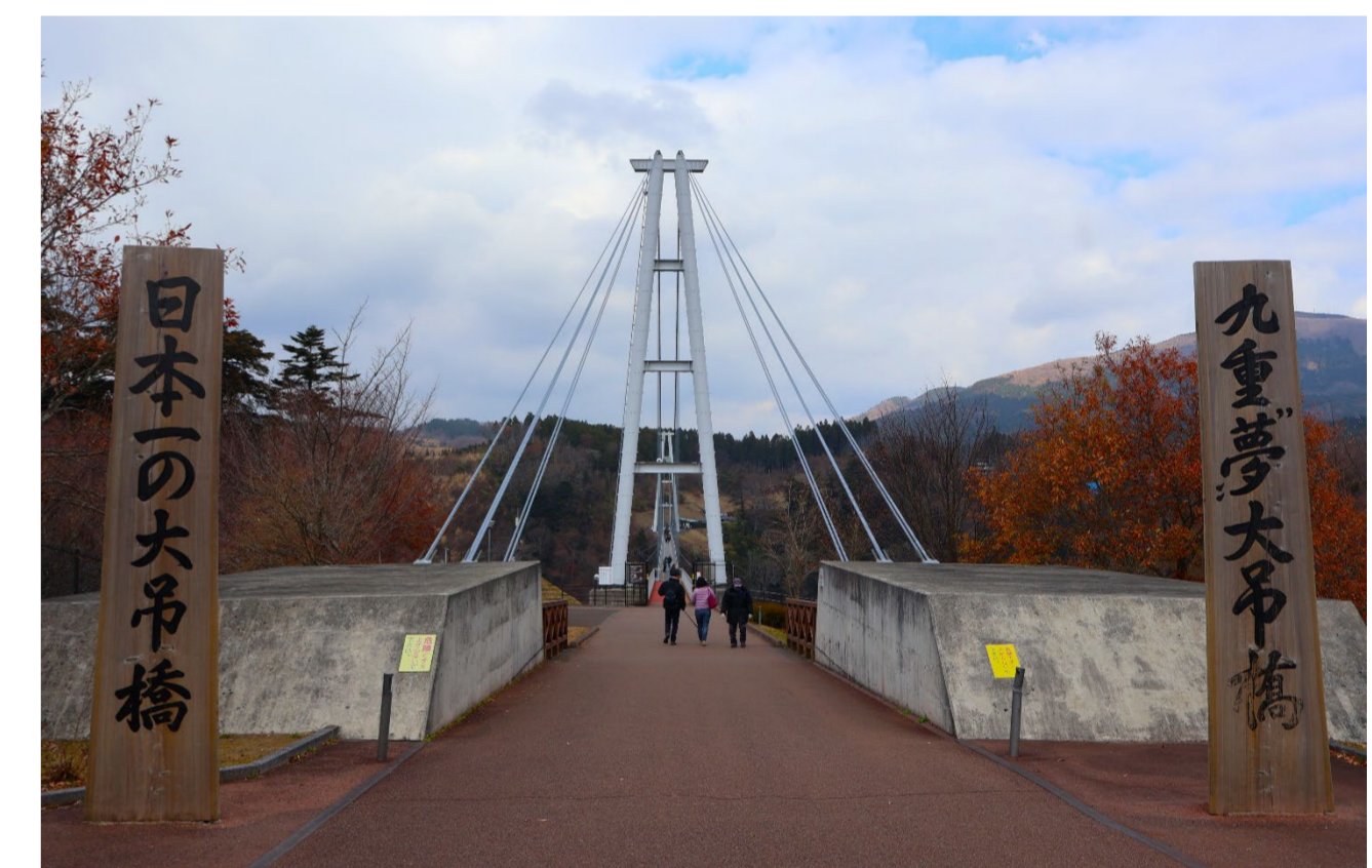
九重夢大吊橋
