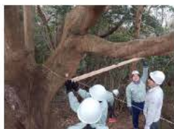
デッキ組立て
