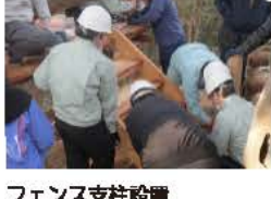
フェンス支柱設置
