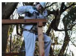
階段の寸法確認
