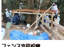
フェンス支柱設置
